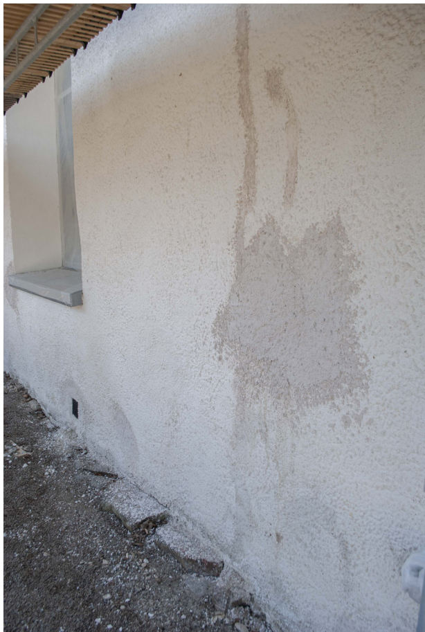
Fasaderna blästrades rena och större skador putslagades.
