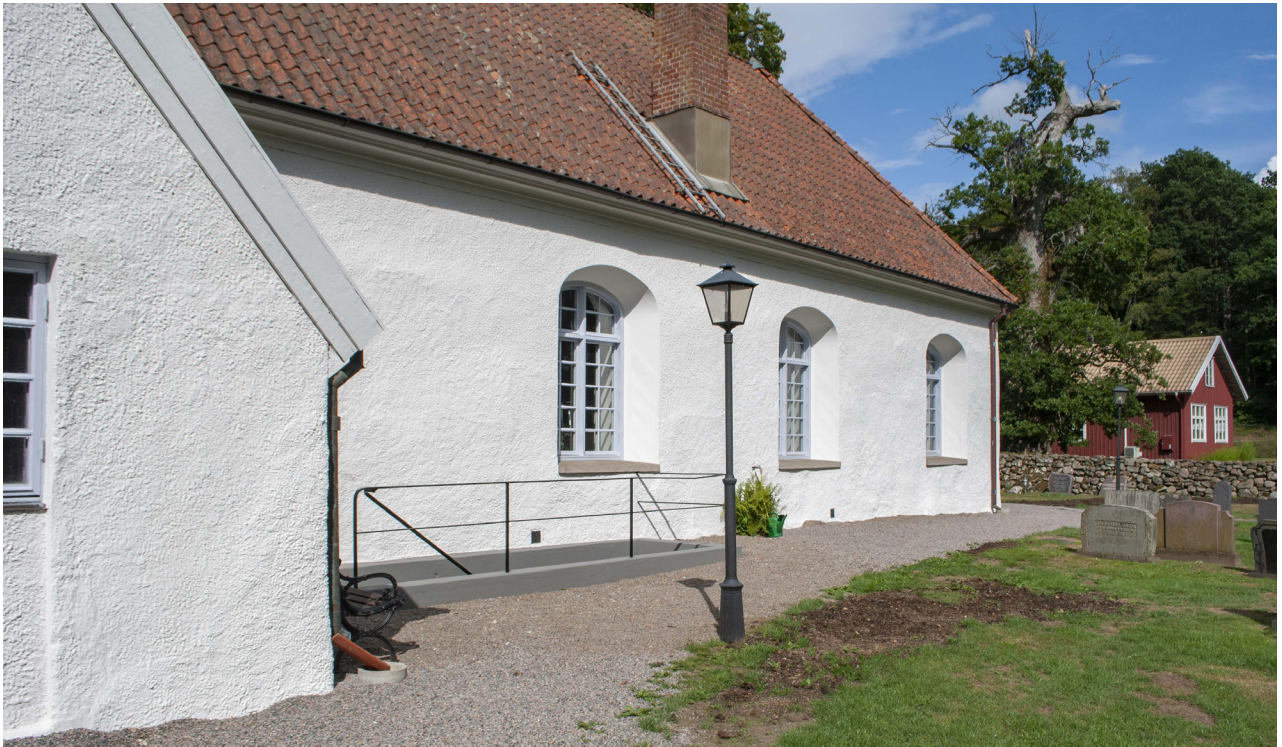
Trappan till källaren har lagats och målats. Räckena har rengjorts och målats svarta.
