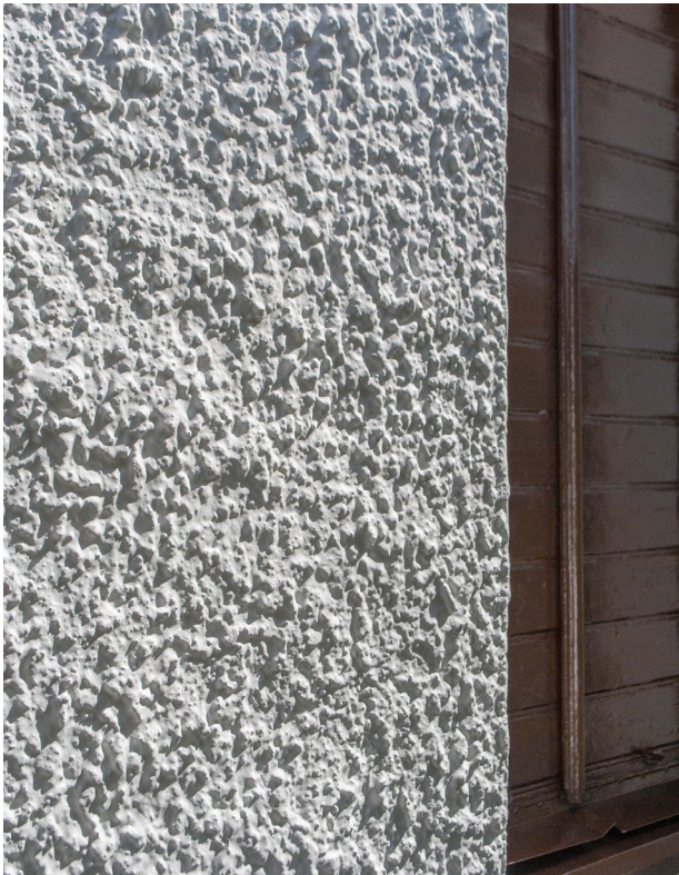
Den nymålade takfoten och nyrenoverade putsen på fasaden. Nedan: Detalj av putsen efter renoveringen samt en bit av en ljudlucka.
