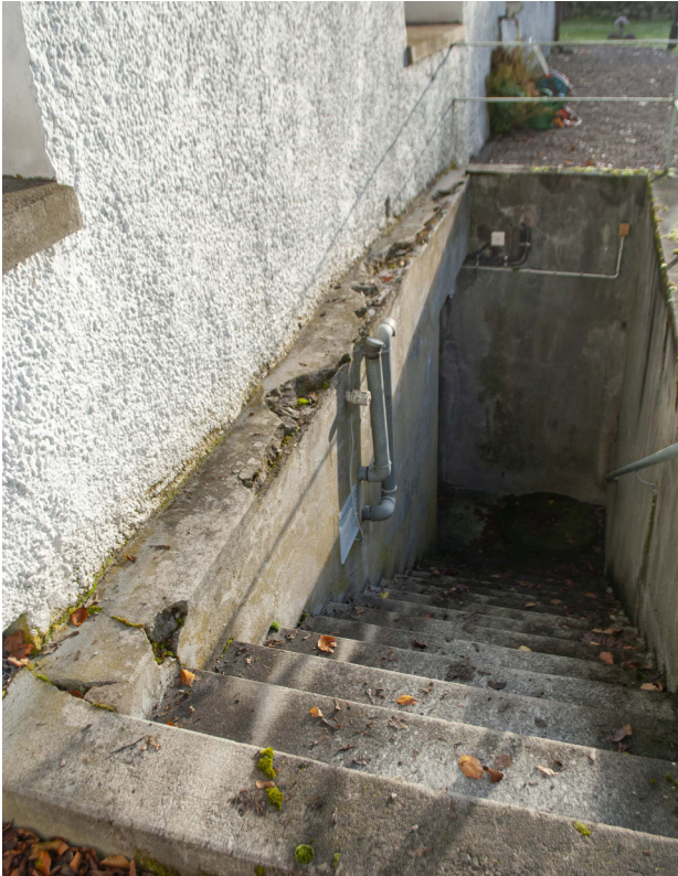
Trappan till källaren var i stort behov av lagning och räcket var rostigt.
