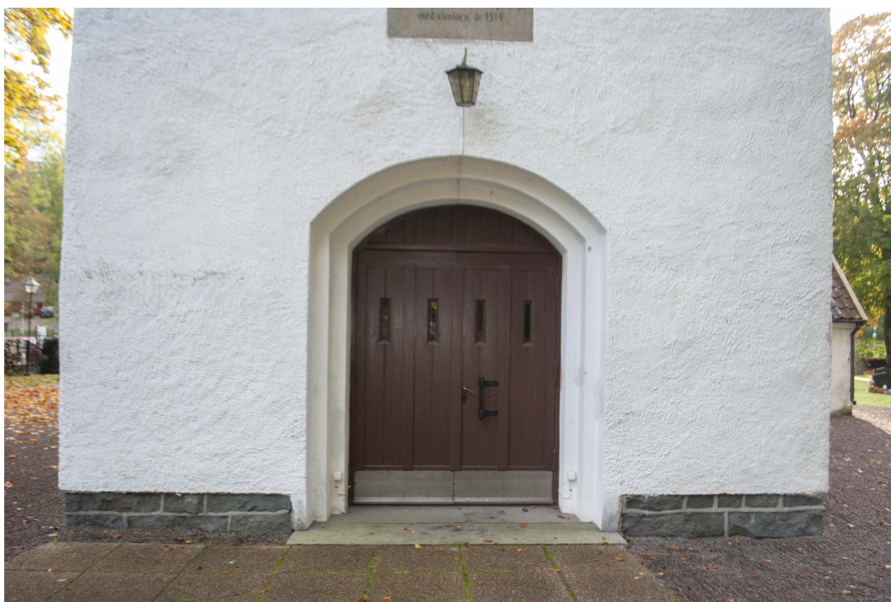
Västporten i tornet innan renoveringen.
