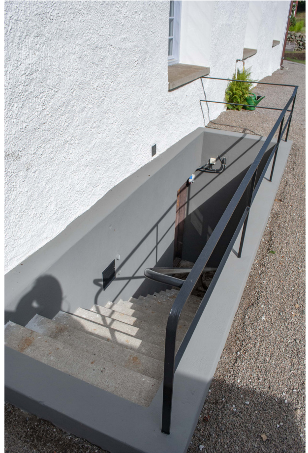
Trappan till källaren har lagats och målats. Räckena har rengjorts och målats svarta.
