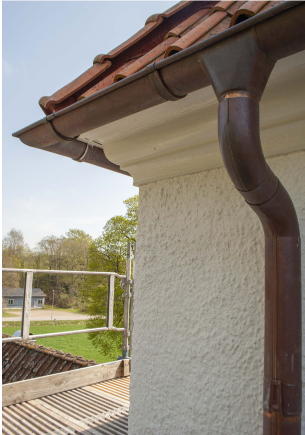
Den nymålade takfoten och nyrenoverade putsen på fasaden. Nedan: Detalj av putsen efter renoveringen samt en bit av en ljudlucka.
