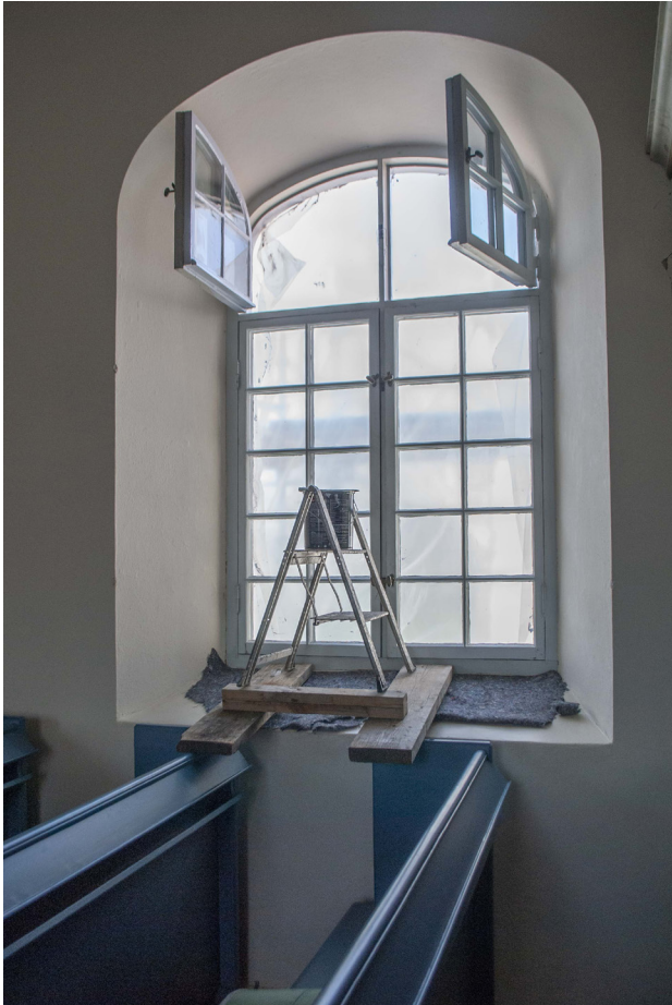
Fönstren målades utvändigt. Eftersom de öppnades inåt kunde målningen ändå ske inomhus.
