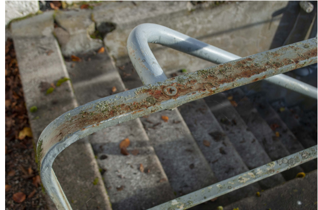
Trappan till källaren var i stort behov av lagning och räcket var rostigt.
